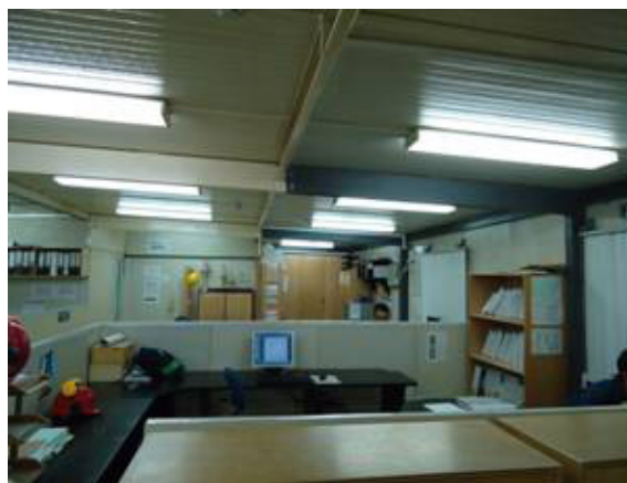
Fig. 2. Disposición actual de las luminarias en oficina
